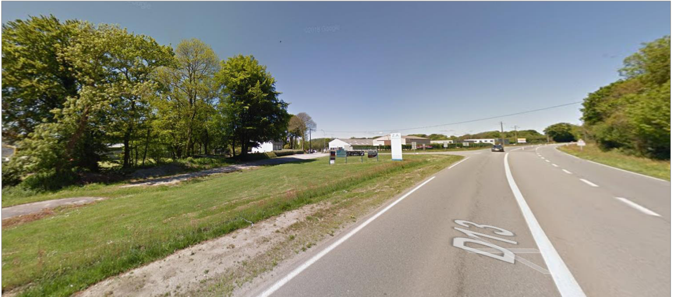
Figure 27 : 1 : Abords de la ZA Breignou Coz depuis la route D13 (source : Google Street View)
