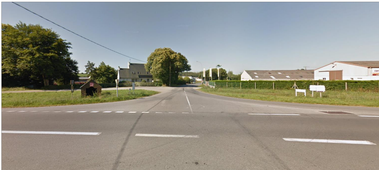
Figure 28 : 2 : Entrée de la ZA Breignou Coz (source : Google Street View)
